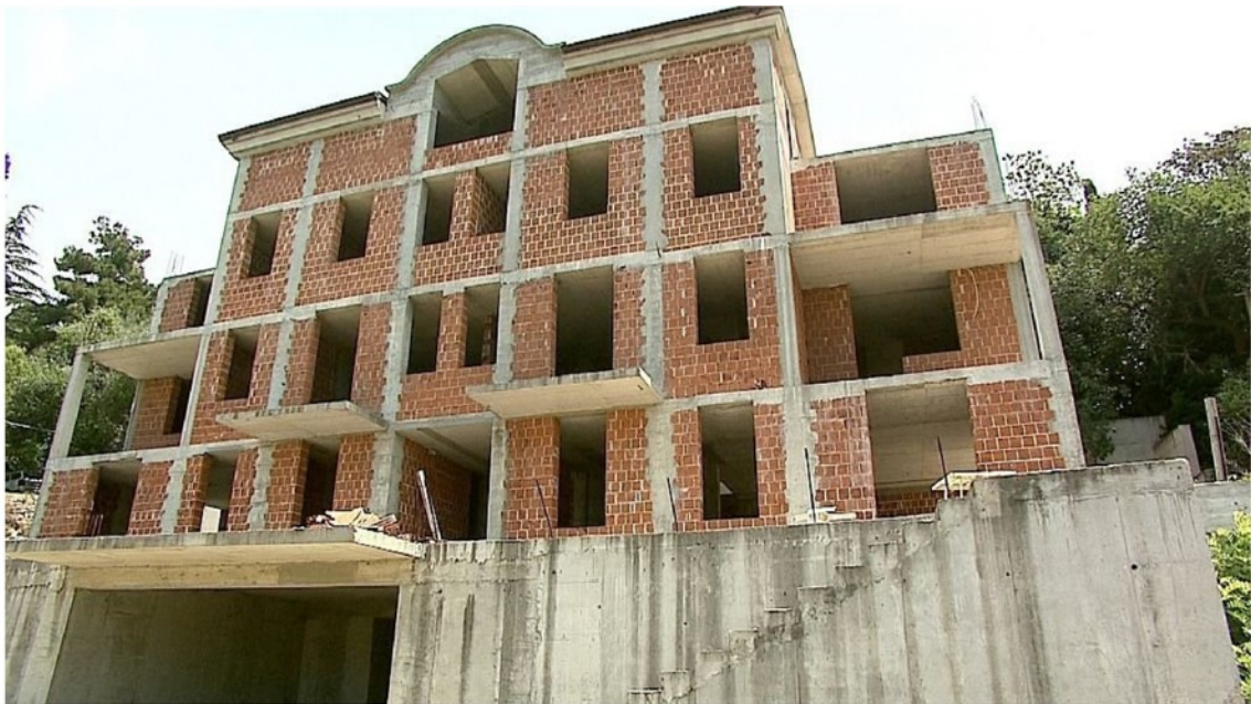
Zidarjeva črna gradnja v Fiesi - 1 FOTO: POP TV
